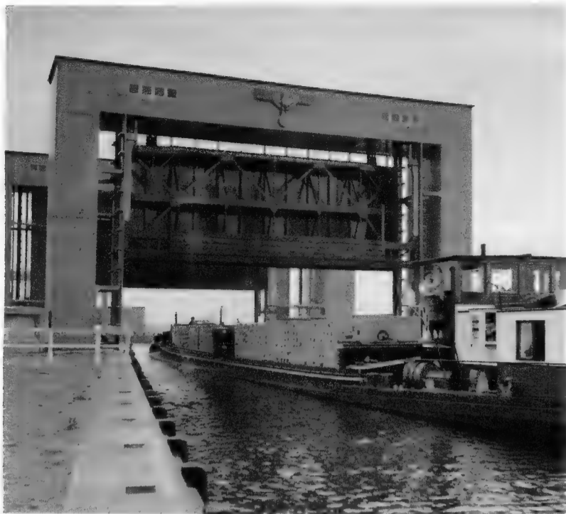
Le chaland s'engage dans le sas d'entrée.
